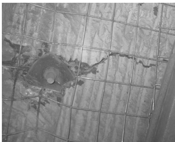
Рис. 8 – Полусферическая шайба на шахте Днепроовская
