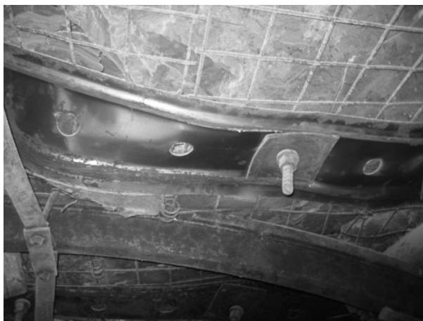
Рис. 7 – Первый этап деформирования полусферической шайбы
