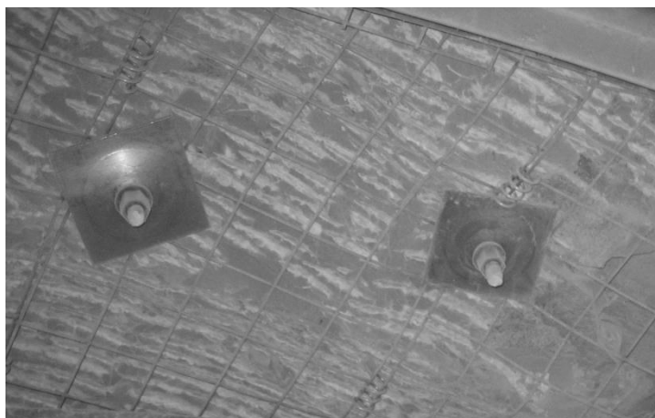
Рис. 6 – Полусферические квадратные шайбы на шахте Павлоградская
